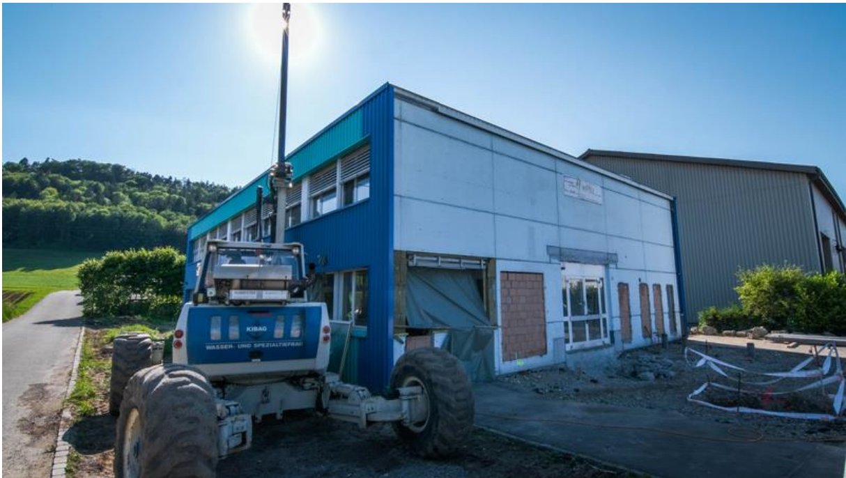
Bild 4: Pfählungsarbeiten wurden am 11. Juni aufgenommen.
